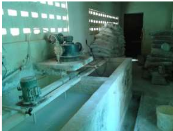
Figura 6. Estação de tratamento com cal e cloro.
