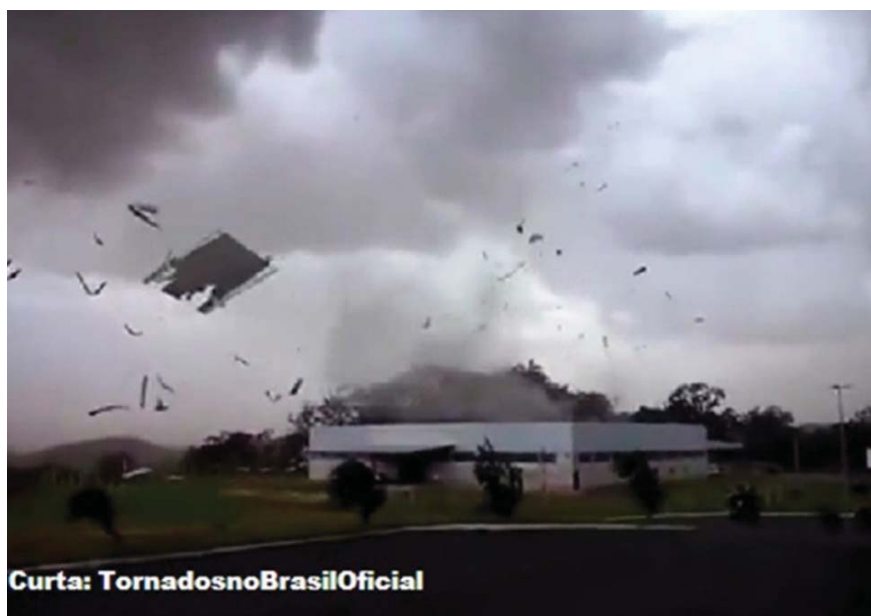
Figura 4 – Efeitos causados pelo tornado que atingiu Pérola d’Oeste, PR.
